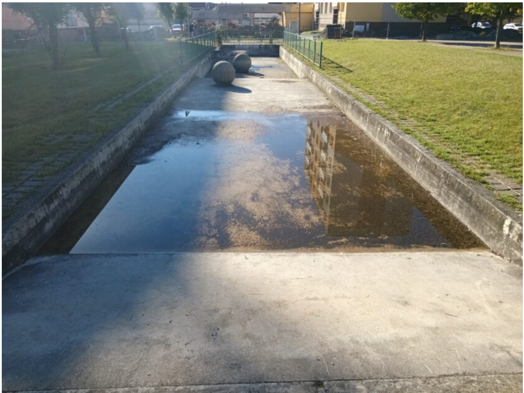
Pohled do útroby stávajícího vodního prvku
